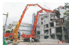
写真10 旧本館の解体工事で、8階建ての6階を解体中。
