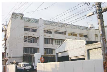
写真4 解体される旧南館を東の道路から眺めた写真。酸素供給タンクも見える。
