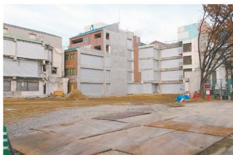
写真11 旧本館解体工事終了。瓦礫はなく、整地されている。
