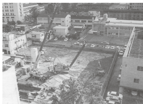
写真 1 新南館の杭打ち工事開始の風景。右が法務局。右上が地方裁判所。左上は倉敷中央病院の方向。
