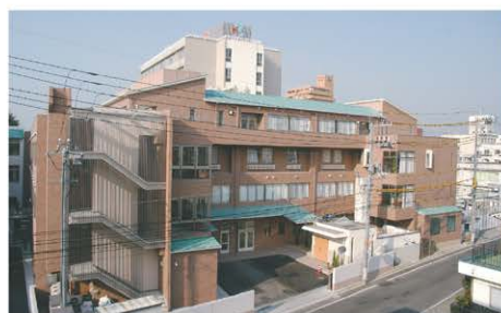
写真5 本館増改築が完成し、旧本館8階の一部も改修され一体化された。
