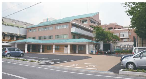
写真14 新本館の第2期工事完成。左に透析管理棟4階が残っている。
