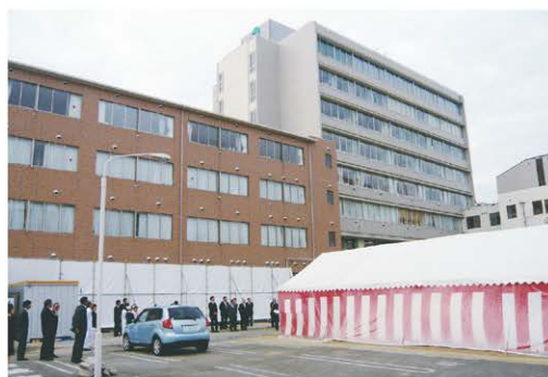
写真6 新本館第1期工事の地鎮祭。新しい本館と旧本館と透析4階。
