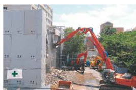
写真9 旧本館解体工事の始まり。旧南駐車場よりアプローチしている。
