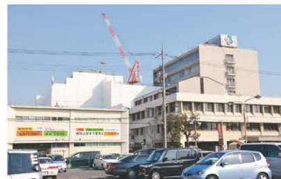
写真7 新本館第1期工事完成まであと少しの工事中。
