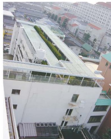
写真3 本館の増改築のため解体される旧南館を旧本館8階の建物から撮影。右奥に倉敷中央病院が見える。手前は新南館への旧連絡通路と現在のリハビリテラスの位置。
