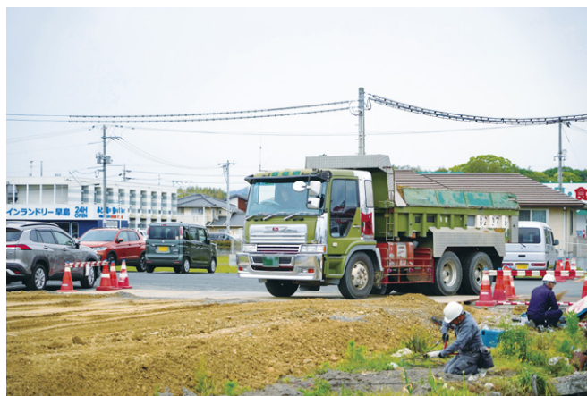
▲造成工事がスタートしました
