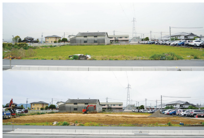
▲造成工事前（上段）と4月24日時点（下段）の様子
