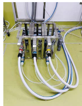
▲フロア透析液配管も全て新しい物に交換
