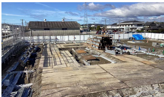
▲基礎工事が終了。3月には鉄骨工事に入ります
