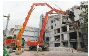
写真10 旧本館の解体工事で、8階建ての6階を解体中。
